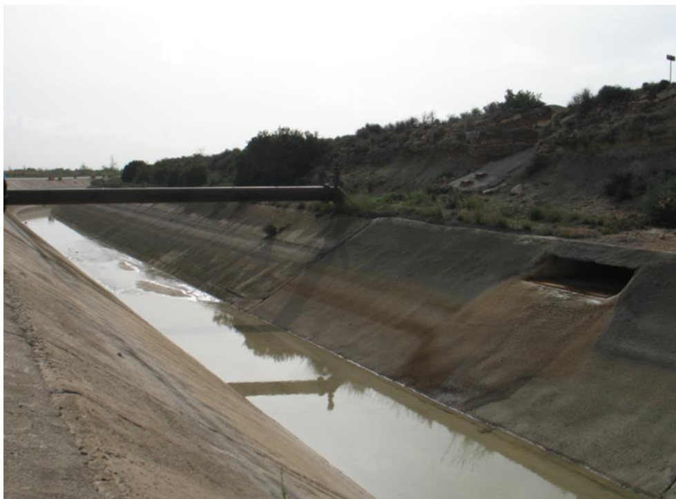
Entorno del punto de control DST-V02 Se observa la tubería que llega hasta la estación de bombeo de la desaladora.
