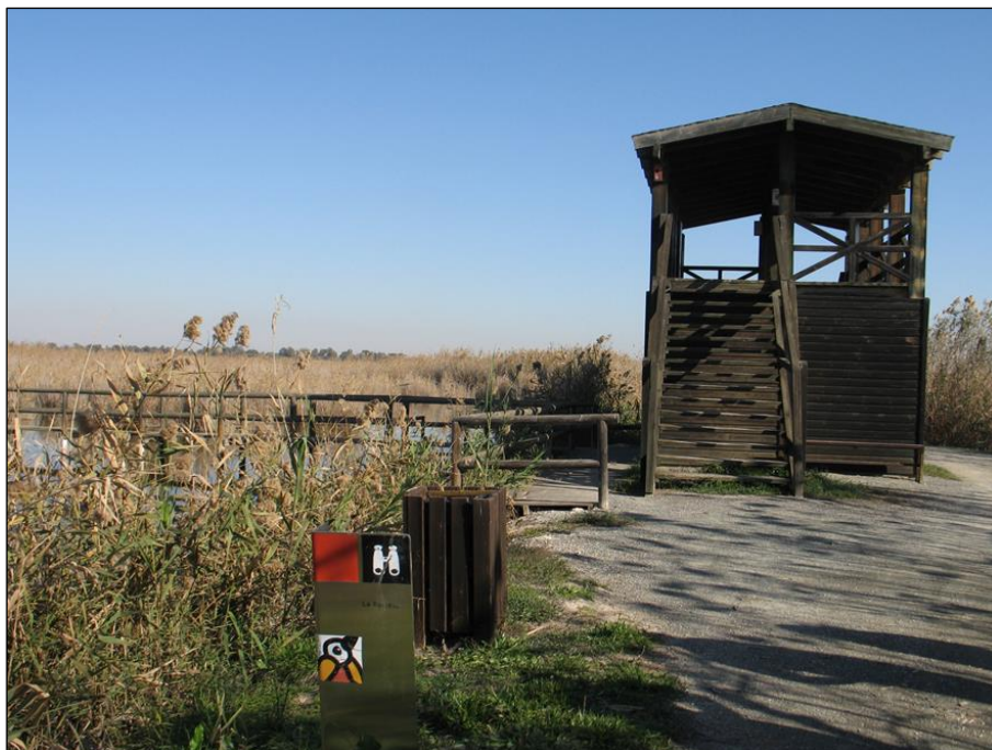
Observatorio de avifauna y pasarela junto al punto de control LHONOR.
