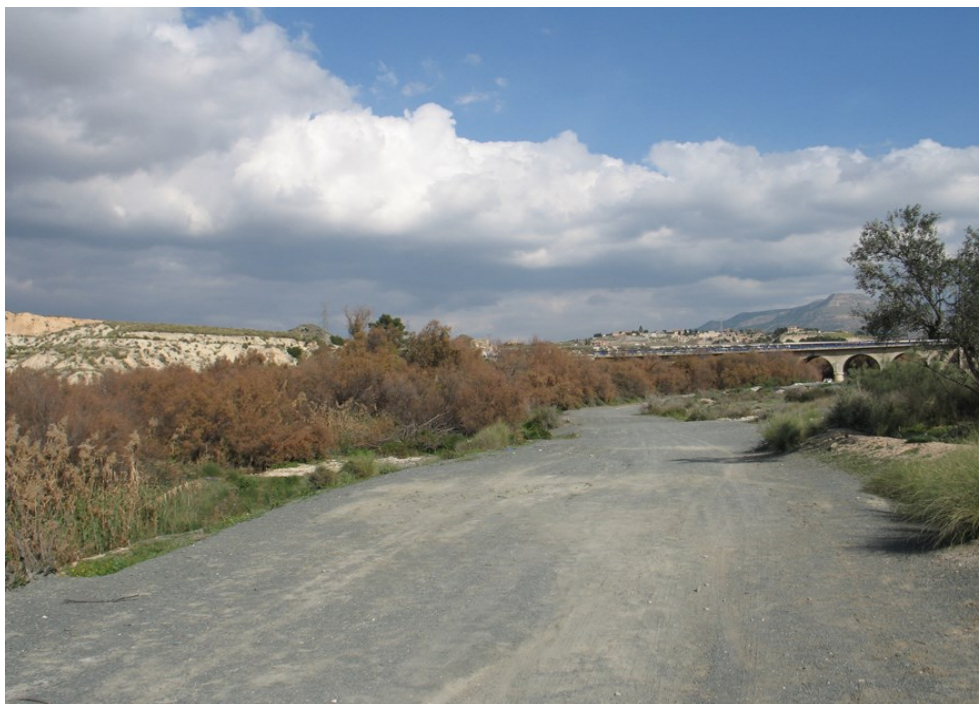
Entorno del punto de control MOR3.
