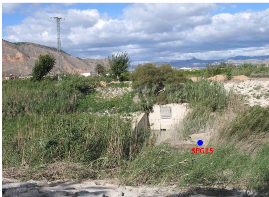
Punto de control SEG15. Visto desde la margen derecha del río Segura.
