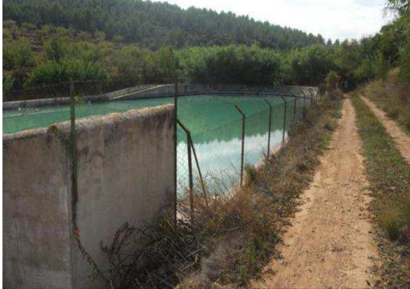
Foto 3.12. Balsa de la Fuente de Ucenda. Al fondo, junto al arbolado, se sitúa el nacimiento. La altura de agua en la balsa es pequeña.
