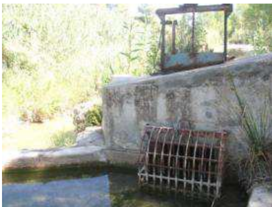
Toma del canal de la CR de Mula
