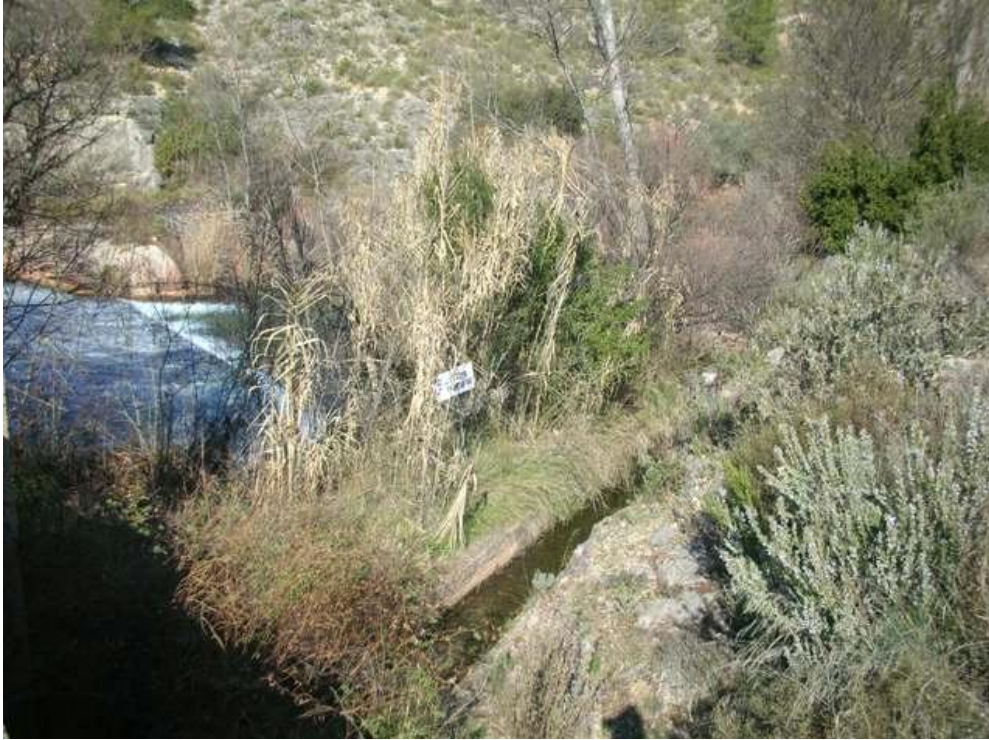
Acequia margen dcha
