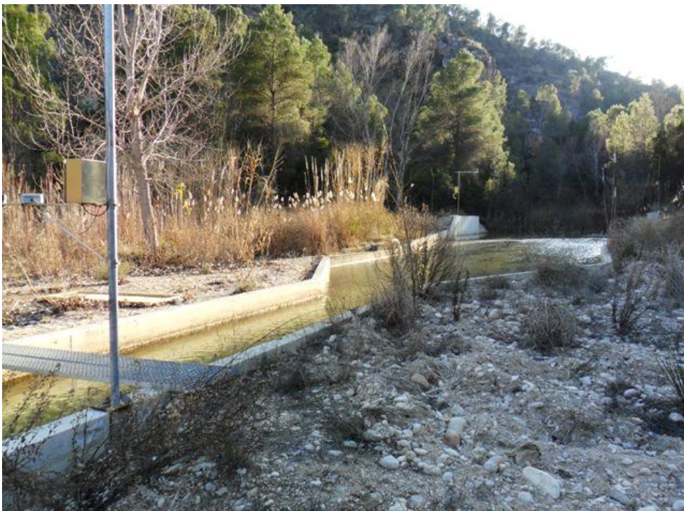
Estación de aforos
