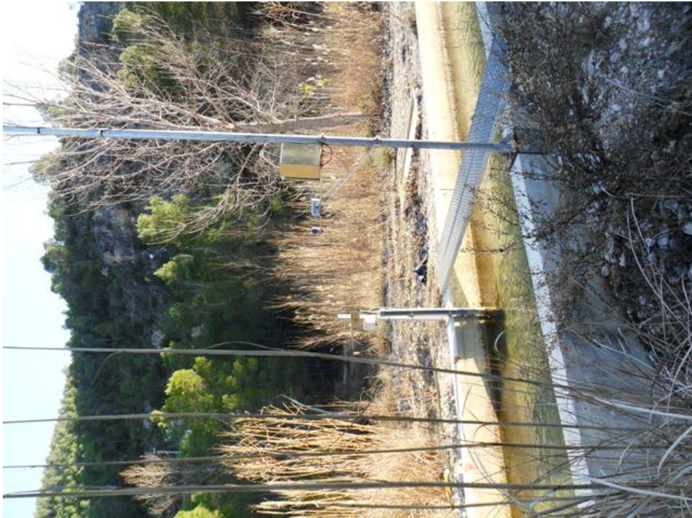
Estación de aforos
