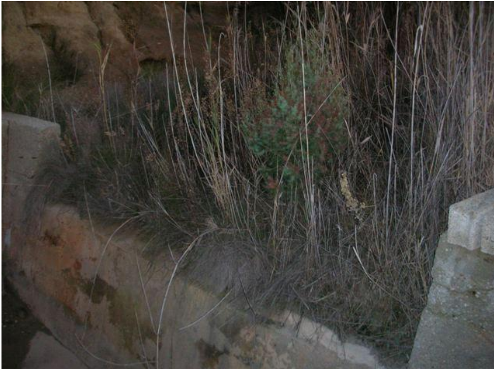
Detalle del vaso colmatado
