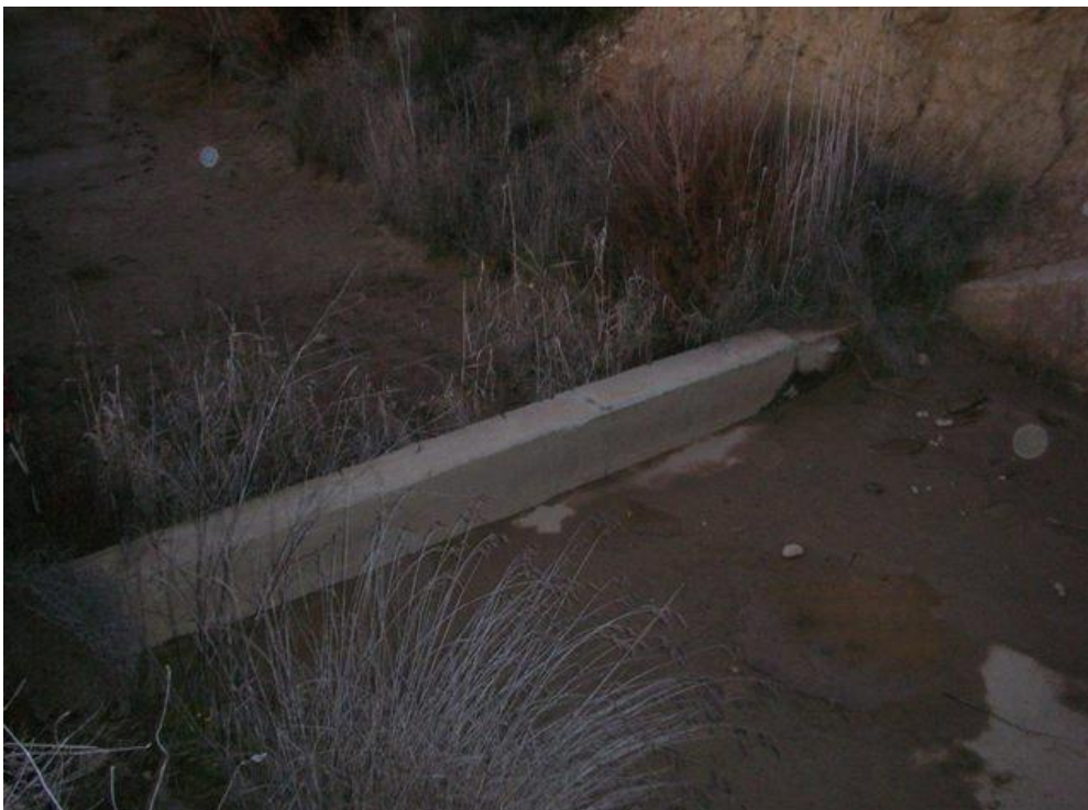
Salto aguas abajo
