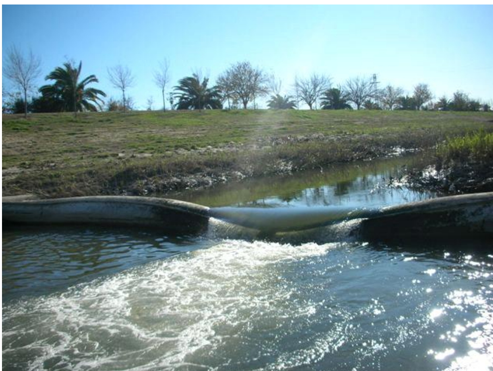
Azud aguas arriba
