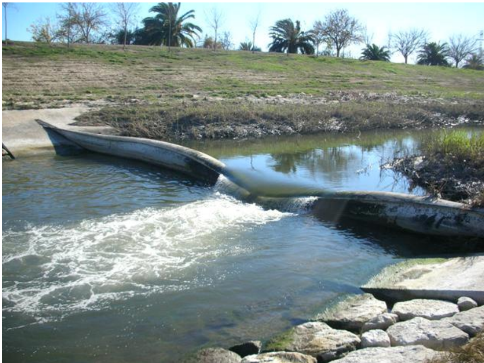
Azud aguas arriba
