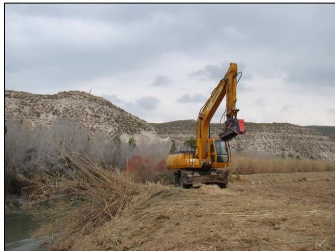
**Figura 3.2.16:** Compactación temporal del suelo en algunas zonas de actuación por uso de maquinaria pesada.
