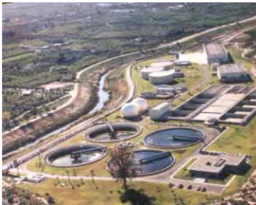
Figura 31 Imagen de la depuradora Murcia Este
