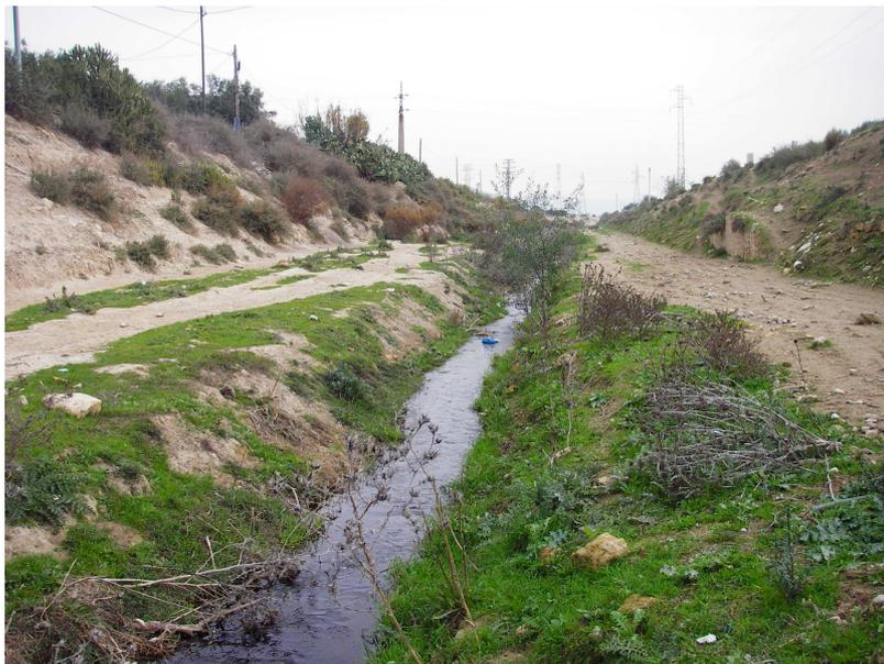
Fotografía 3. Canalización trapezoidal realizada en tierra donde se intercalan tramos con obra de fábrica y mampostería. Río Segura en Rojales. Fuente: Comisaría de Aguas de la CHS.
