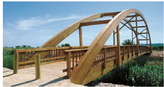
Pasarela en el Meandro de Jacarilla
