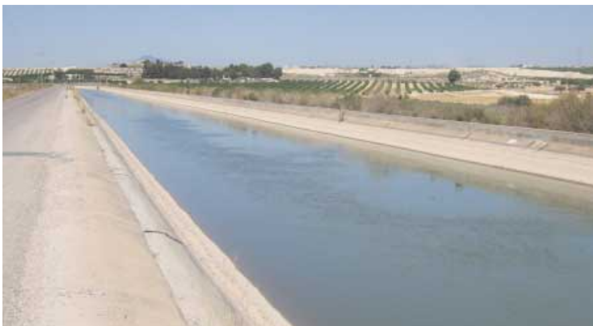
Canal principal de la M.I. del postravase Tajo-Segura
