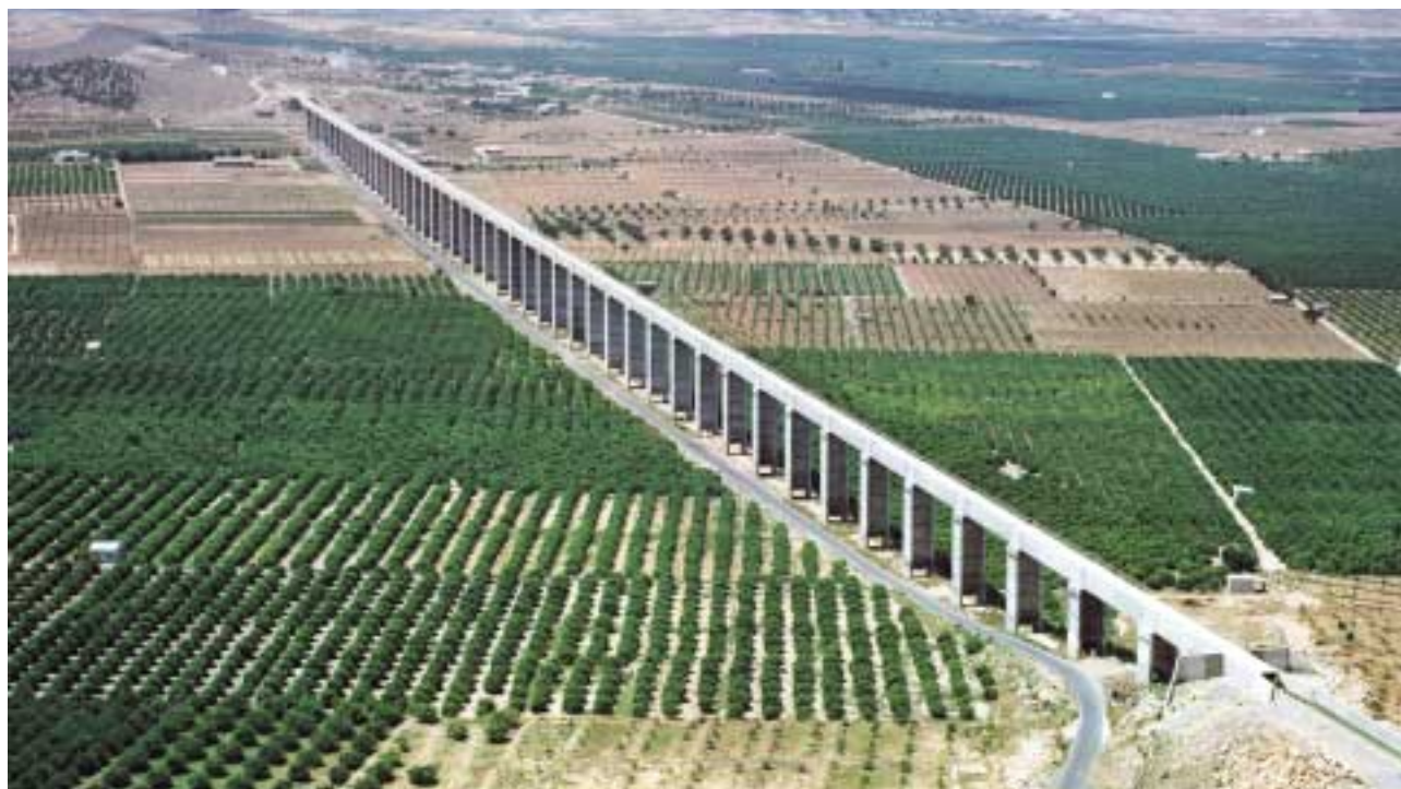
Acueducto de La Matanza del postrasvase Tajo-Segura
