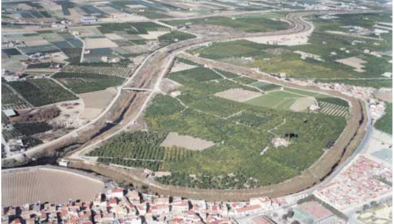
Encauzamiento Río Segura
