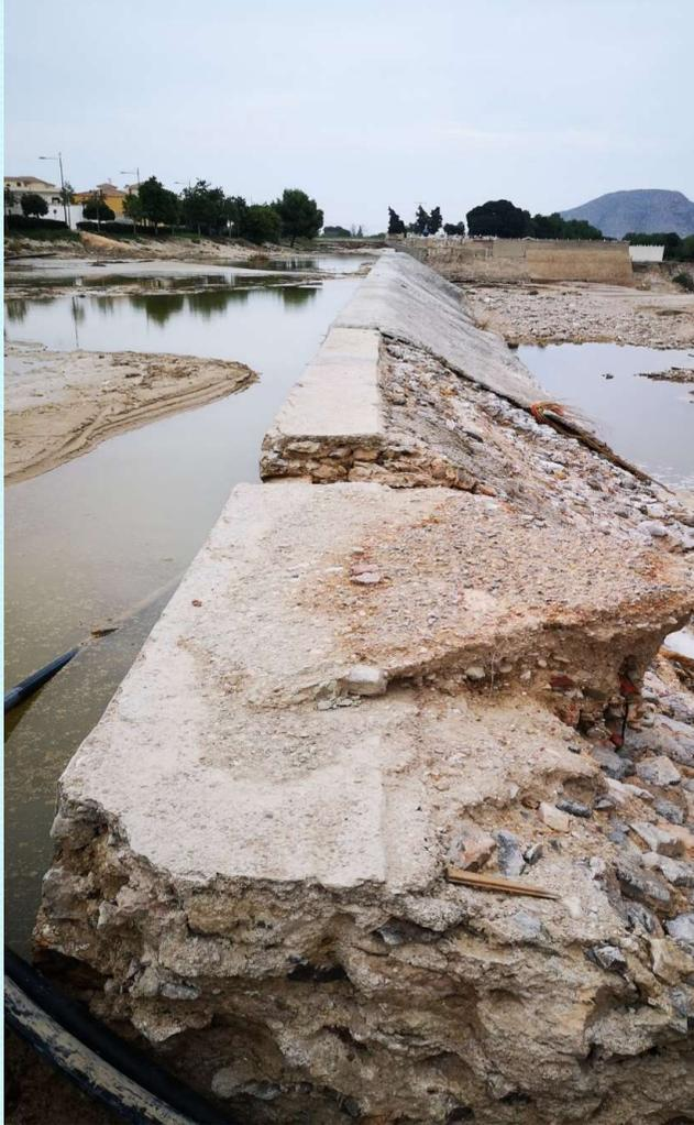
**2.- Vista de la rotura de la mota en la margen izquierda del río Segura, aguas abajo del azud de Alfeitamí (Alicante)**
