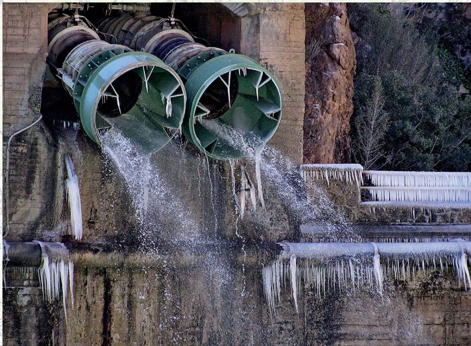
Desagüe de la toma intermedia del embalse del Cenajo.
