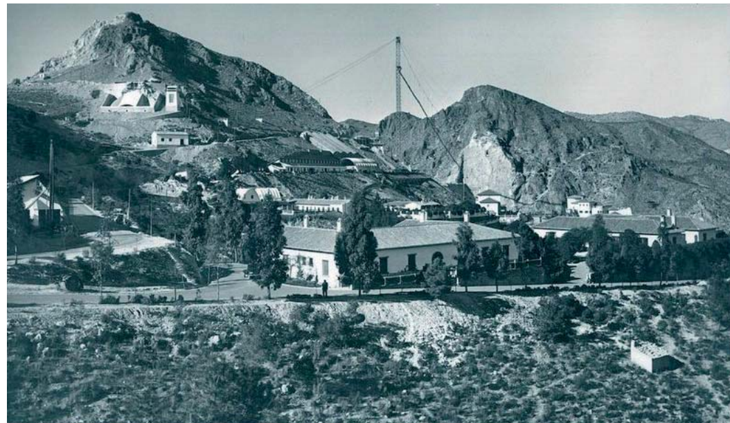
Vista general de las obras de embalse del Cenajo.
