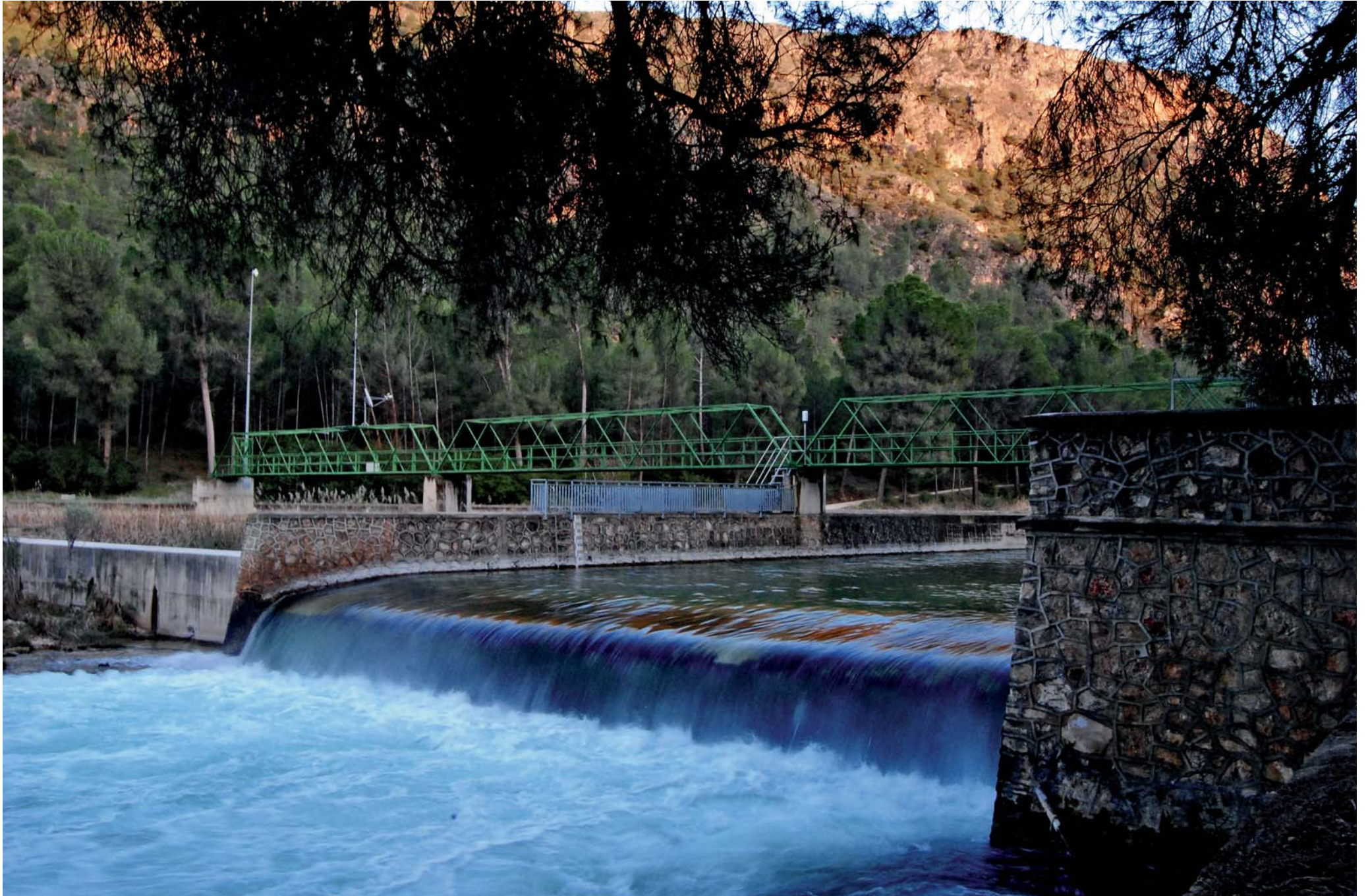
Estación de aforos, aguas abajo del embalse del Cenajo.
