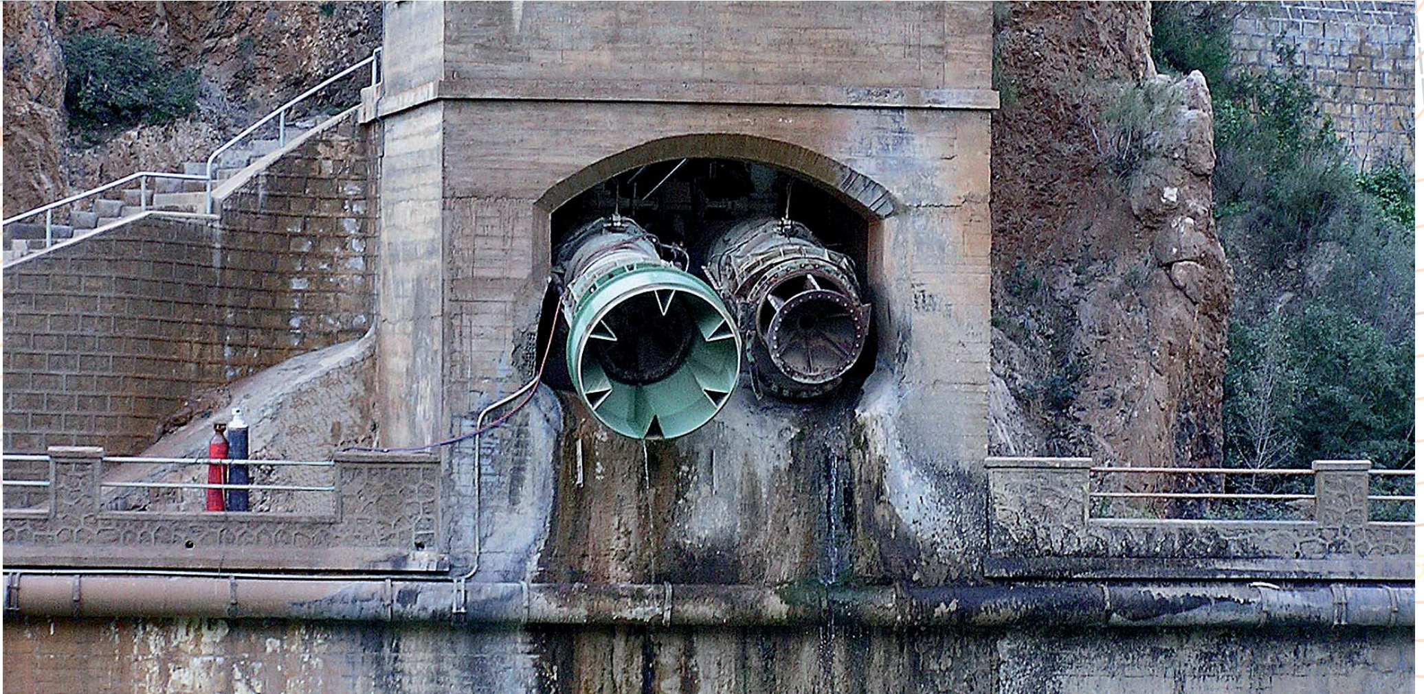
Trabajos de reposición de los concentradores de las válvulas Howell-Bunger en el desagüe de la toma intermedia.
