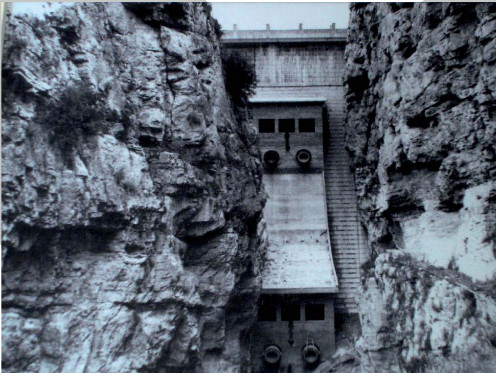
Vista del cuerpo de presa del embalse de Camarillas aguas abajo. Imagen tomada poco después de la finalización de las obras.
