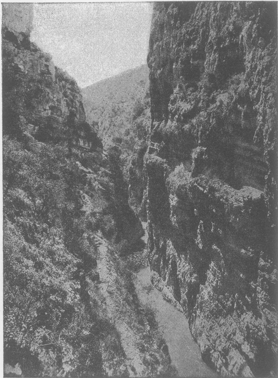
Aspecto de los almaderes del Rio Mundo, inmediatamente aguas abajo de la Presa del Pantano
