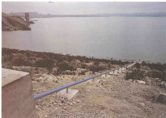
INSTALACION DE MEDIDA DEL NIVEL DE EMBALSE
