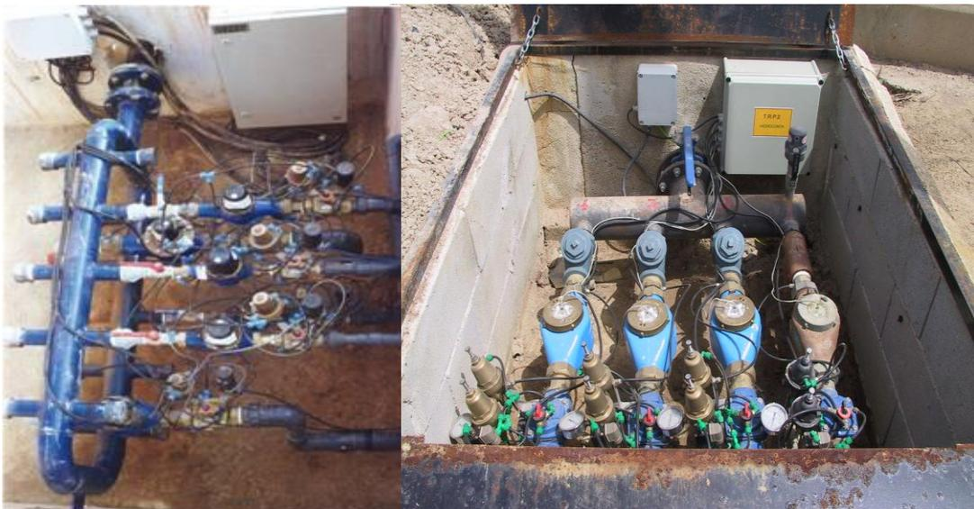
**Figura 3.4.** Tomas de derivación a parcelas (hidrantes multiusuario). Izquierda: válvula manual + contador + válvula hidráulica con solenoide. Derecha: filtro + contador + válvula hidráulica con solenoide.
