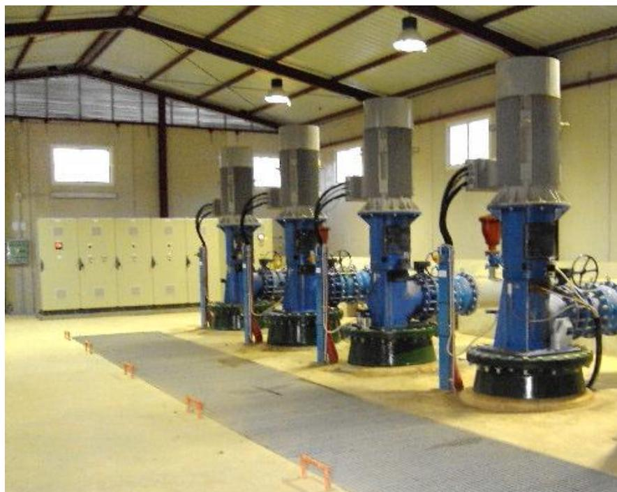
**Figura 4.4.** Grupos de bombeo de la impulsión de la Trinchera en la Comunidad de Regantes del Campo de Cartagena.
