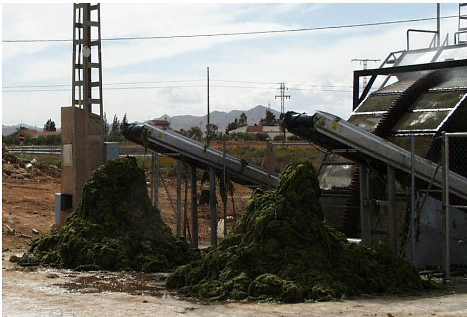
**Figura 3.6.** Filtro tipo noria en derivación en tubería principal de la Comunidad de Regantes del Campo de Cartagena.
