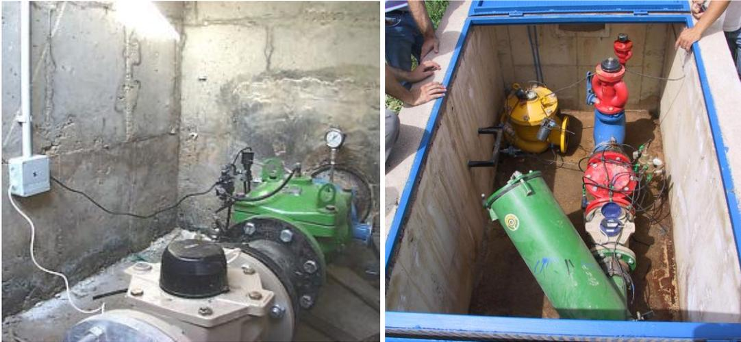
**Figura 3.3.** Arqueta de derivación en tubería secundaria. Izquierda: contador + carrete + válvula hidráulica con solenoide + manómetro. Derecha: filtro cazapiedras + contador + válvula hidráulica con solenoide + ventosa (en amarillo hidrante: contador + válvula hidráulica).
