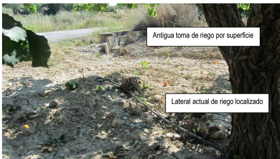
Figura 4.12. Sustitución riego tradicional por riego localizando en parcela en la Comunidad de Regantes Pantano de la Cierva.
