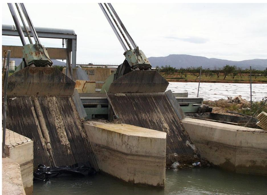
**Figura 3.5.** Filtro limpia rejas situado al final del Canal Principal del Campo de Cartagena.
