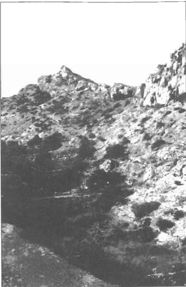
Fig. 65.- Diques de consolidación de sedimentos. Barranco de Roldán
