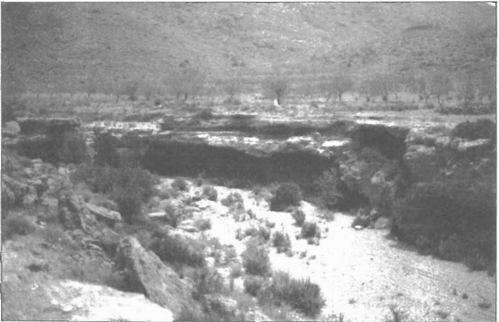
Fig. - 45. Margen de tipo mixto con potente encostramiento superior. Rambla de las Torres
