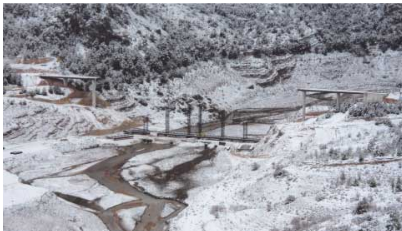
Puente de la Vicaria, sobre el Río Segura, en Yeste (Albacete)
