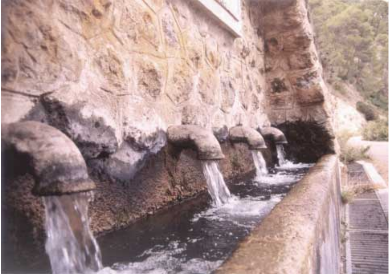
Fuente de los "Cuatro Caños". Santiago de la Espada (Jaén)
