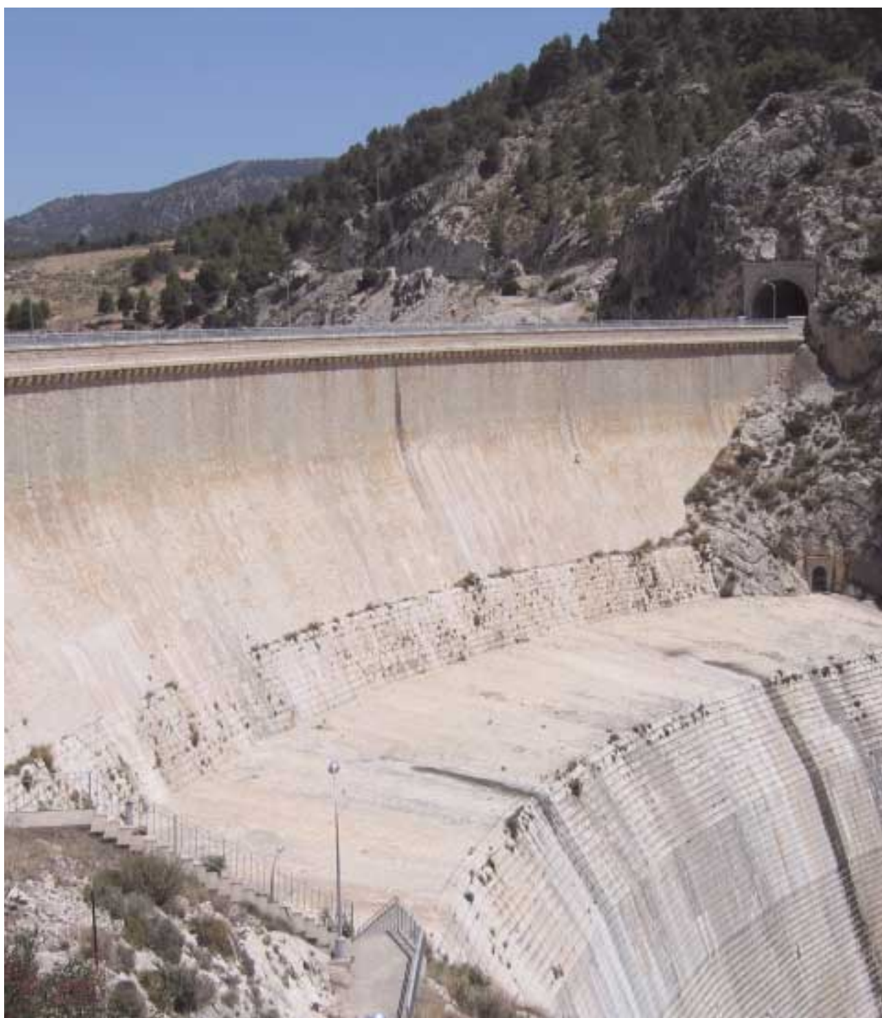
Presa de Valdeinferno en Lorca (Murcia), 1806
