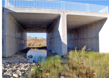
Marcos de hormigón. Tres marcos adosados con una longitud total de 25m y una anchura de 13,5m sobre la rambla de “los Barrancos”. Para ello, se prepara la superficie sobre la que descansan las estructuras mediante la excavación del terreno superficial, vertido de hormigón de limpieza y extendido de una última capa de arena para terminar de nivelar y homogeneizar el apoyo de los marcos.
