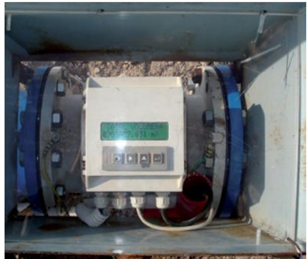
C.V. electromagnético (sensor y visor en carrete de montaje). Placa de metacrilato. No manipulable
