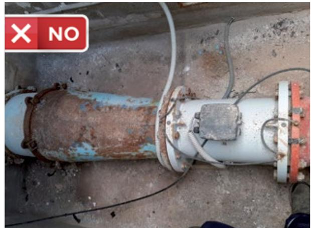
Contador electromagnético junto a reducción de la tubería. No cumple
