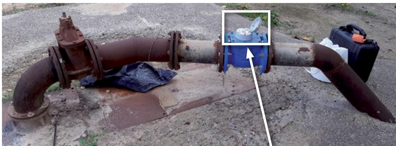
C.V U0D0: No precisa tramos rectos de conducción aguas arriba y abajo del C.V.
