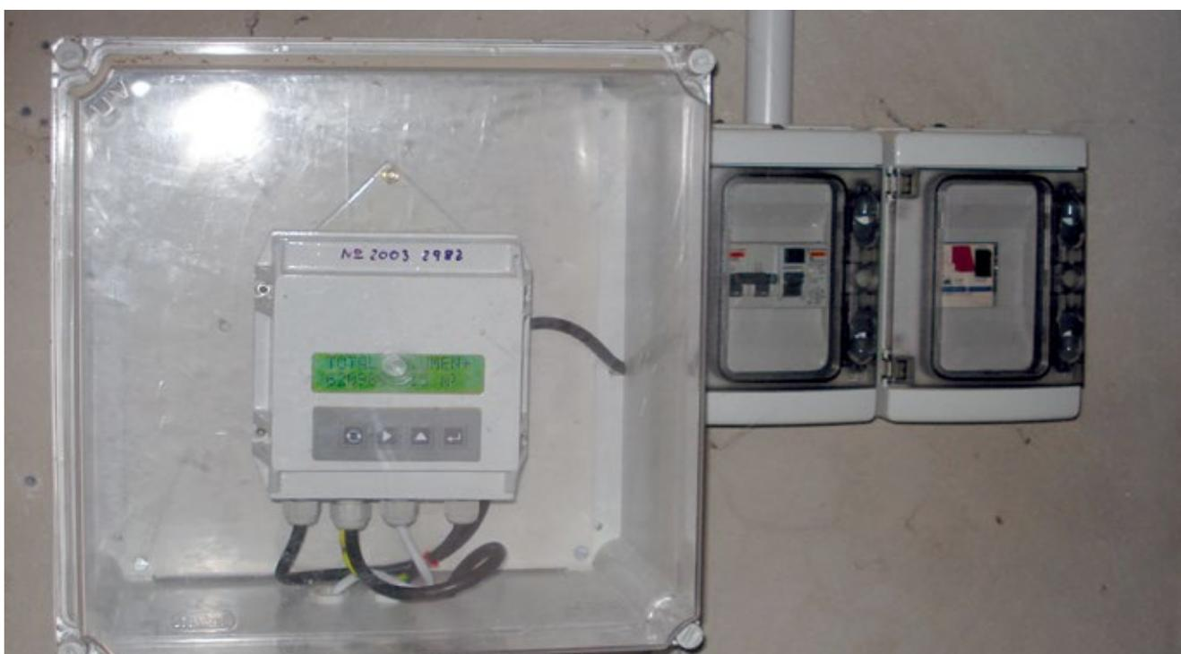
Visor y magnetotérmicos de C.V. en cajas independientes no manipulables
