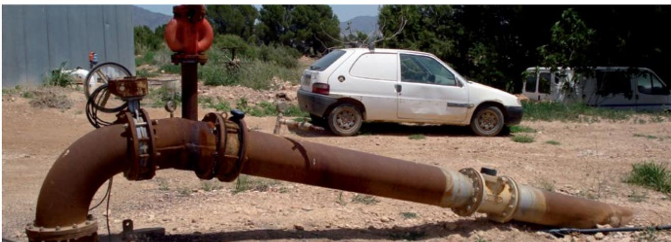
Contador en tramo descendente (válido si la tubería está en carga o existe válvula de retención detrás del C.V.)
