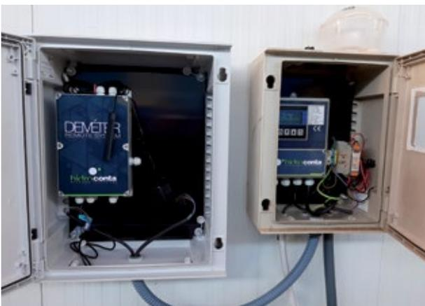
Equipo transmisión automática de datos junto a visor de contador electromagnético
