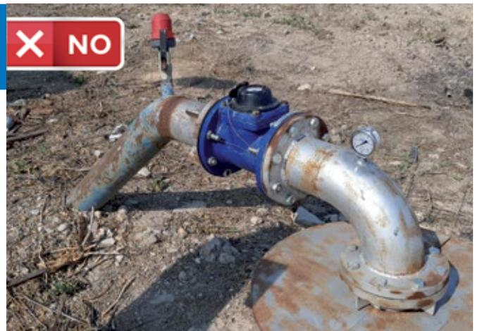
Actualmente existen en el mercado modelos de contadores que no requieren tramos rectos al dotarse de estabilizadores de flujo u otros mecanismos, lo que puede comprobarse en la documentación del contador y en el propio cuerpo del mismo U0/D0
