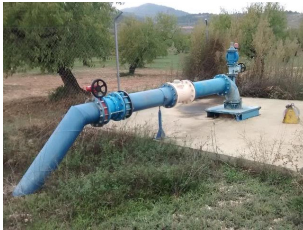
Figura 2.113. Pozo C.R. Férez. Se trata de un pozo situado a escasos 200 m del nacimiento de la Fuente de Férez, con una afección directa al caudal del manantial, incluso llegando a secarlo. Se les solicitará el volumen bombeado.
