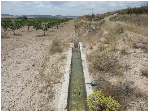
Figura 2.79. Fuente de La Mina. Recientemente los regantes han entubado el agua en su nacimiento y no se puede aforar en la acequia. Se contactará con los usuarios para tratar de realizar las mediciones en otra sección.
