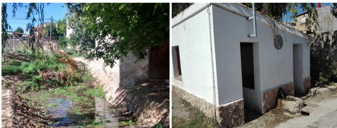
Figura 2.68. Fuente La Pinilla. Aforo volumétrico.
