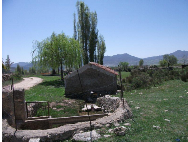
Figura 2.48. Fuente de Zaén de Arriba. La sección de aforos construida continua en perfecto estado.
