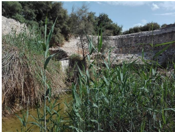
Figura 2.53. Fuente Rambla de La Raja. Se trata de un pequeño manantial relacionado con las aguas subterráneas de la rambla y sin relación con el acuífero Ascoy-Sopalmo. Se realiza un aforo volumétrico. El acceso al manantial es difícil.
