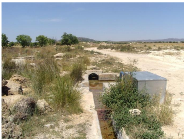
Figura 2.11. Fuente de Albatana. Manantial afectado por los bombeos de la CR de Albatana en un pozo situado a 2000 metros del manantial. Se visitará para controlar su posible recuperación.
