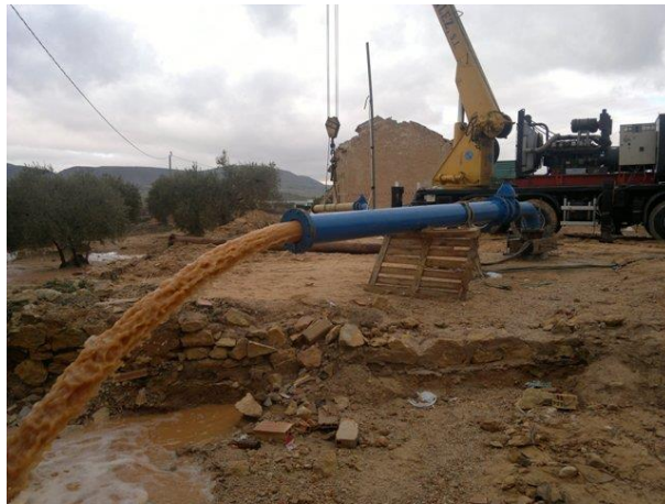
Figura 2.116. Sondeo Contreras-Fuente de Hellín. Se trata de un sondeo situado a 750 m del nacimiento de la Fuente de Hellín. En él se medirá el nivel piezométrico del acuífero Tobarra-Tedera-Pinilla para ver posibles afecciones al caudal del manantial.
