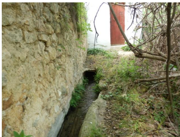
Figura 2.38. Fuente de Férez. Actualmente seca o afectada por bombeos estacionales.
