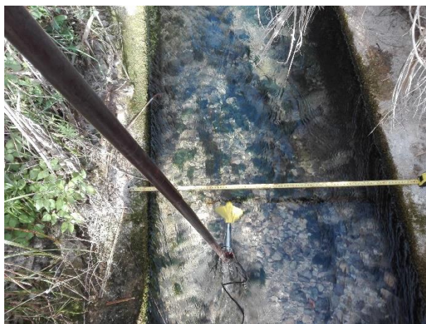
Figura 2.67. Manantial Heredamiento de La Vega. Se debe de limpiar la sección de aforos antes de realizar la medida.
