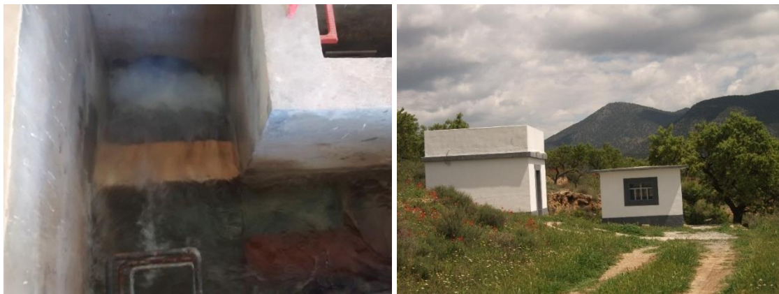
Figura 2.66. Manantial de Loma Ancha. Sus aguas son captadas en el nacimiento por la Mancomunidad de Canales del Taibilla.
