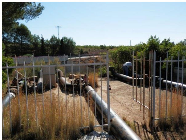
Figura 2.109. Pozos del Boquerón. Se trata de un pozo situado a 1900 m de la Fuente de Isso. El manantial en los periodos de escaso bombeo vuelve a manar. En el pozo se puede tomar el nivel piezométrico y solicitar las extracciones mensuales.
