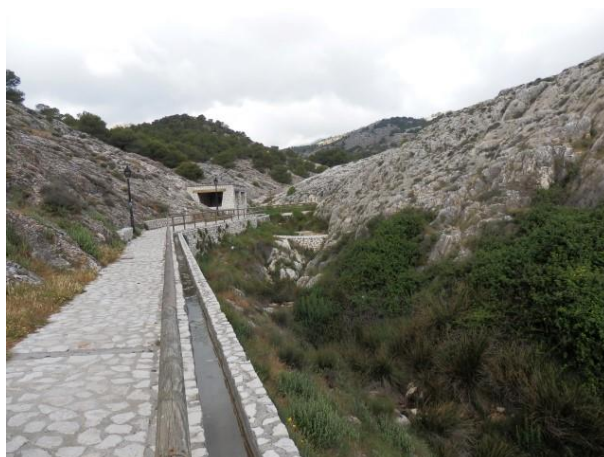
Figura 2.83. Fuente Pago de La Vicaría. Se realiza un aforo más en el barranco de las fuentes, donde se juntan las aguas del manantial Pago de La Vicaría y Caños de Caravaca. Al resultado se le resta uno de los caudales para saber el otro.
