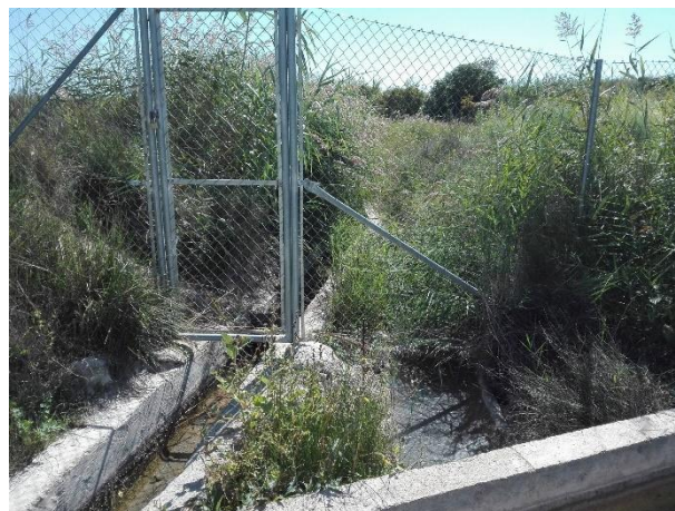
Figura 2.62. Manantial de La Tosquilla. Se debe contactar con la comunidad de regantes para que dejen abierta la puerta de acceso.
