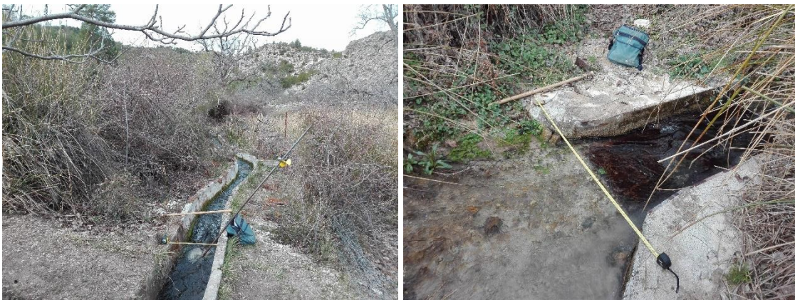
Figura 2.34. Fuente Molino de Las Fuentes. Se realizan 2 aforos diferentes. La sección de aforos que se construyó en 2008 ha sido destrozada por las crecidas de los últimos años.
