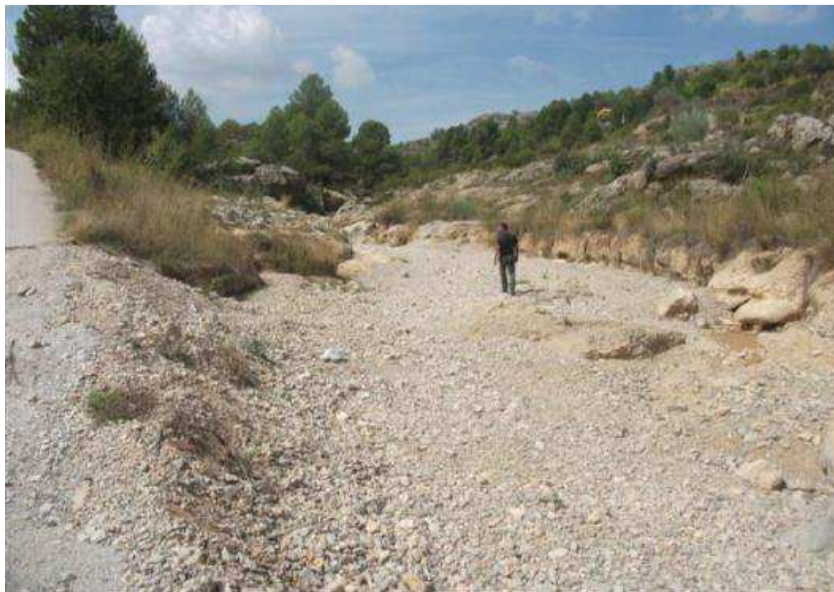
Foto 3.1 Vista general del cauce del río Mula inmediatamente aguas debajo del manantial. Actualmente se encuentra seco.
