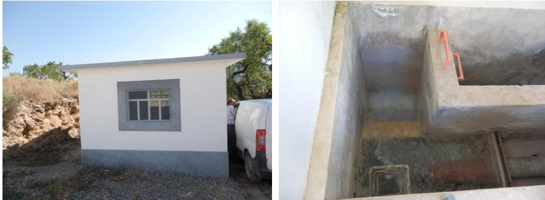
Foto 73. Vista general de la zona y un detalle de la arqueta de llegada del agua del manantial.
