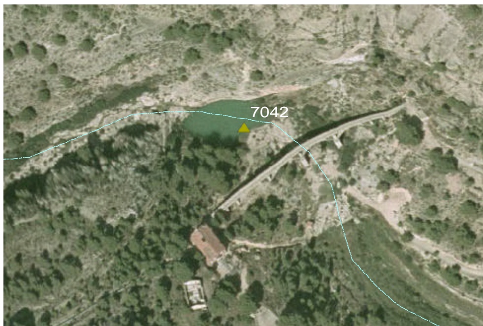
Figura 5: Ubicación aproximada de la estación de aforos 7042, en las proximidades del azud del segundo sector.
