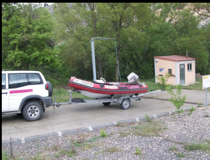
Estación construida por la CHE
