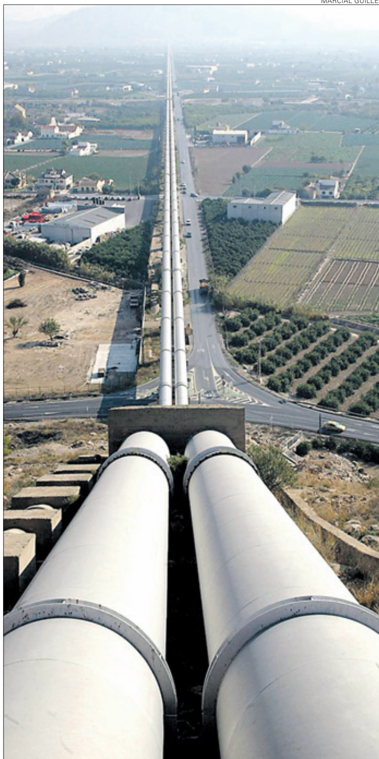
Vista panorámica del canal del Trasvase
