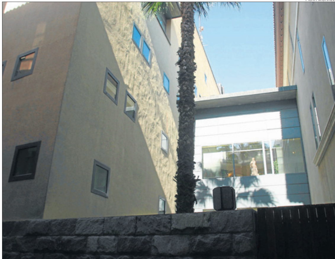
La alineación del callejón del Azuque hace más aparente la separación entre los dos edificios
