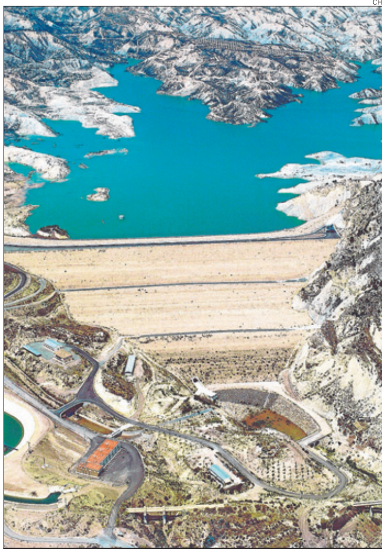
Presa de la rambla de Algeciras
