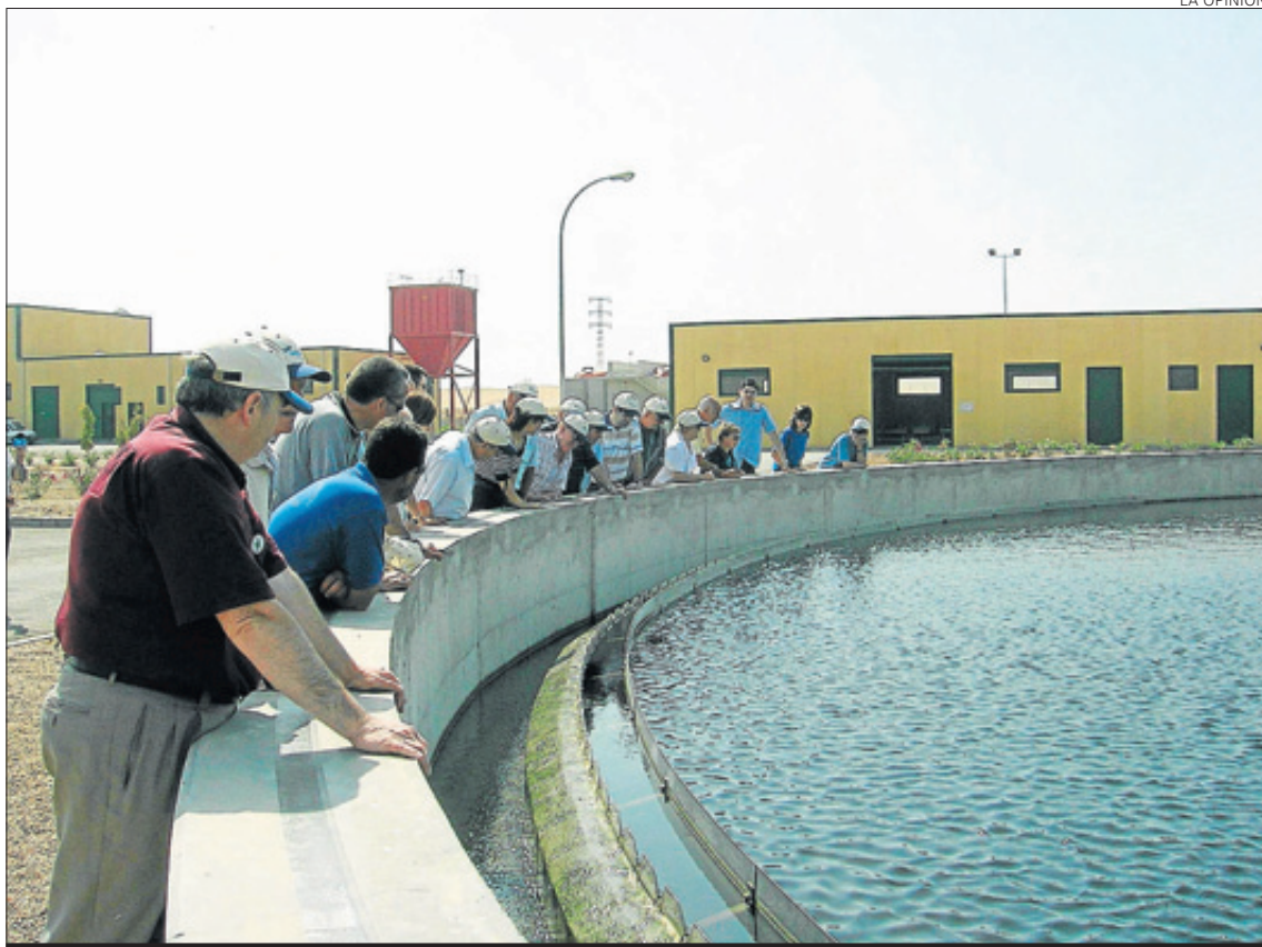
Regantes en la depuradora de Mazarrón
