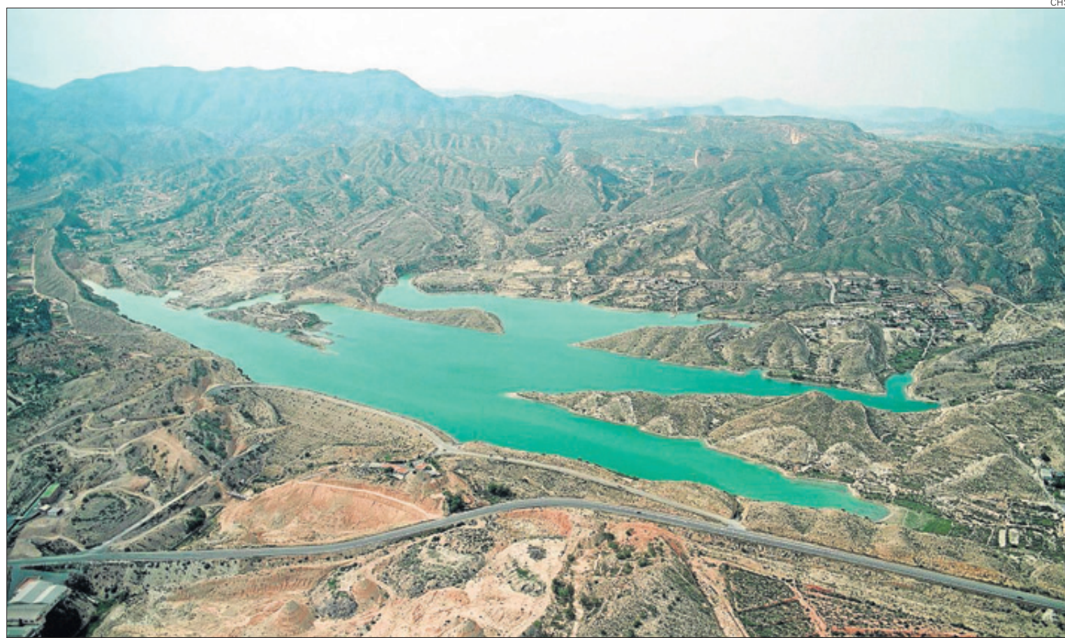
Aspecto del embalse de Crevillente
