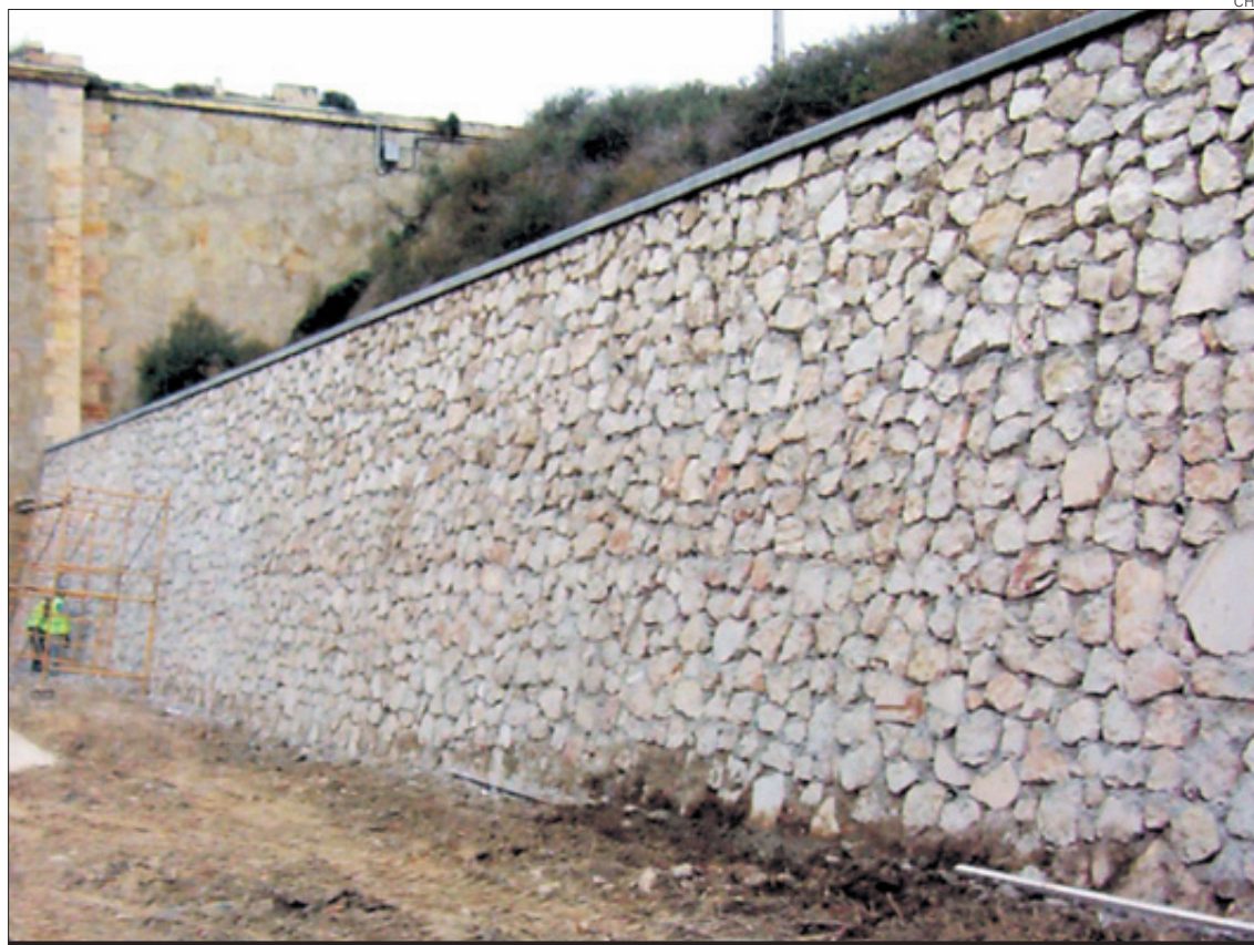
Un tramo del río Pliego ya cuenta con un muro de mampostería que sirve de protección a las casas de la zona
