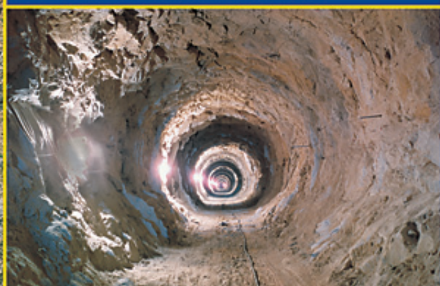
Túnel para el Canal de Crevillente. Alicante. 1986
