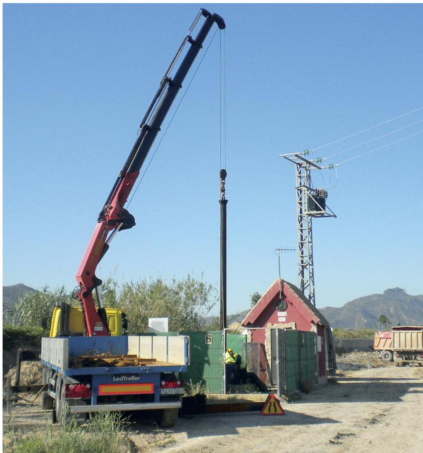
Extracción de la columna de impulsión del sondeo Ortines y revisión de su bomba.
