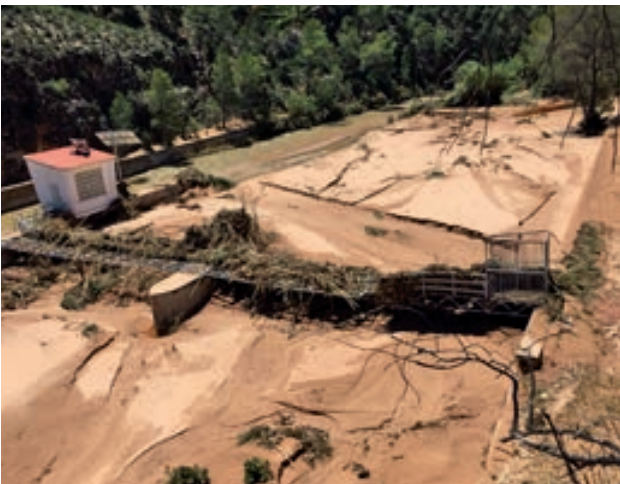
Estación de El Gallego tras la riada y una vez restituida la pasarela y retirados los sedimentos.
