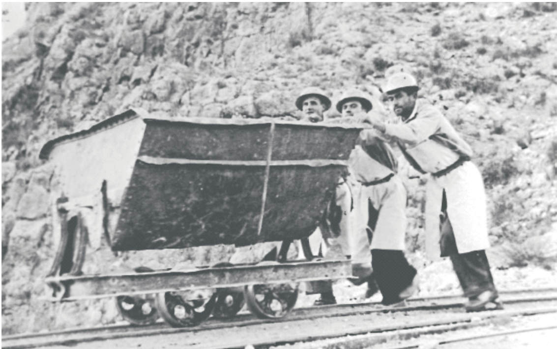
Comienzo de las Obras 1949
