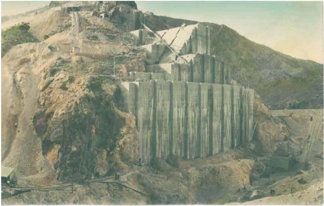
Hormigonado estribo margen derecha (1953).
