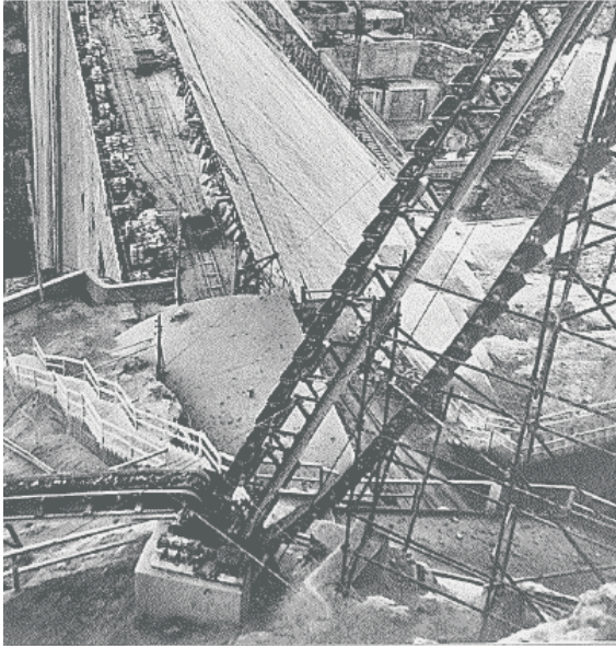
Terminación de la coronación de presa (1959).
