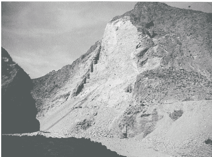
Excavación estribo margen izquierda (1949-1950)
