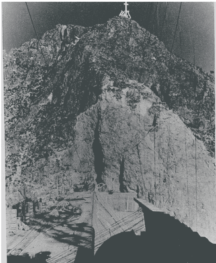
Estribo de la margen izquierda (1955).
