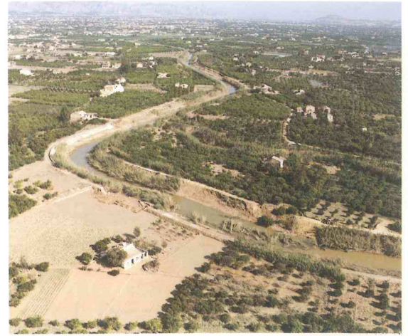
ROTURA DE MOTAS DEL RIO
