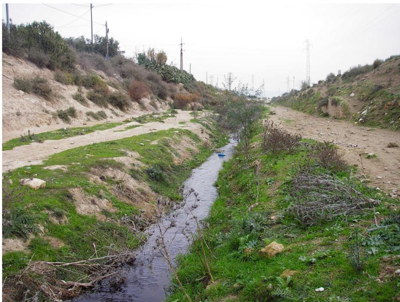
Fotografía 3. Canalización trapezoidal realizada en tierra donde se intercalan tramos con obra de fábrica y mampostería. Río Segura en Rojasles. Fuente: Comisaría de Aguas de la CHS.
