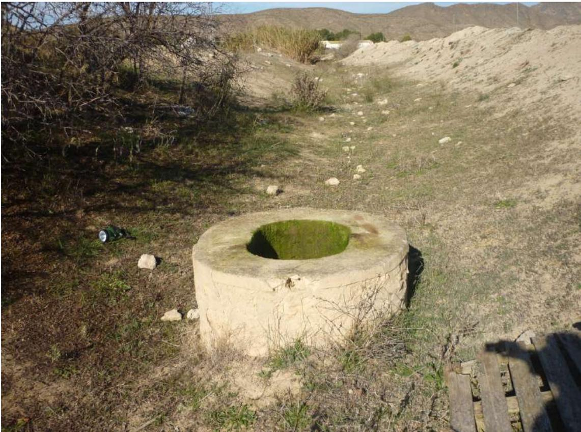
**Fotografía nº 7: Espejuelo o bocamina de la galería aflorando en el lecho del cauce.
