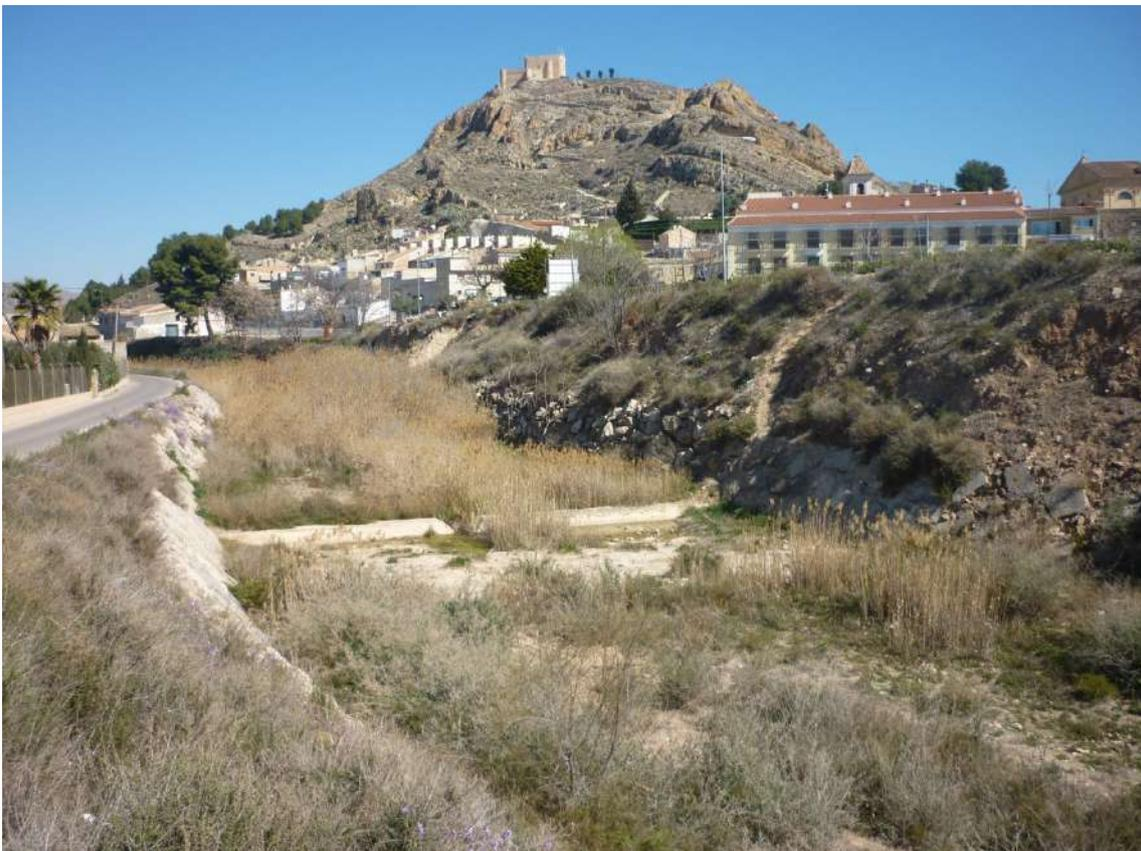
**Fotografía nº 24: Dique del lecho del cauce, donde se aprecia la vegetación y llegada del agua. A partir de este dique hasta el final, se realizaría una canalización de hormigón de 2,30 m. de anchura máxima en su parte superior, para que la lámina del agua se apreciara desde los márgenes del cauce. Parcela Catastral 441, Polígono 154.**
