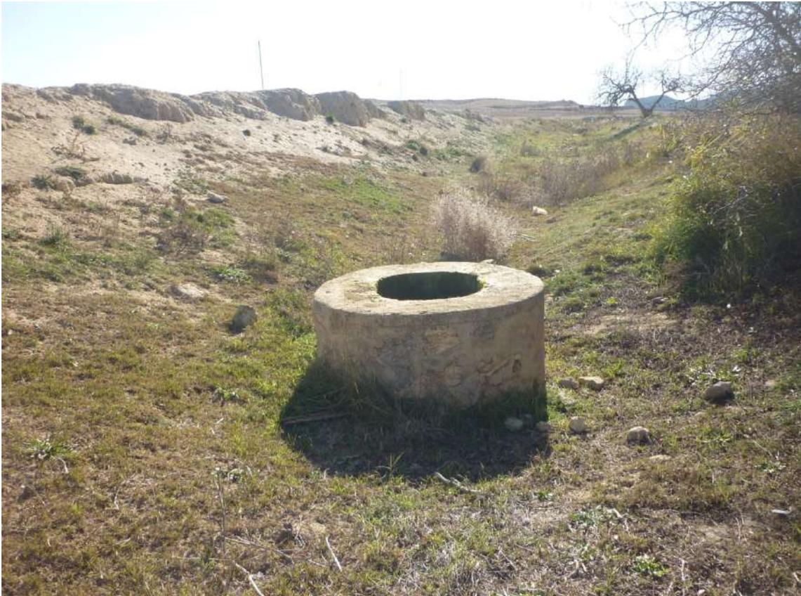
**Fotografía nº 8: Otra vista de espejuelo o bocamina de la galería.
