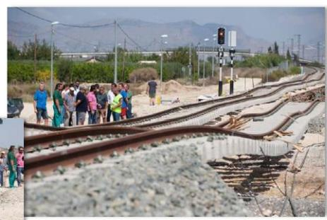
Detalle de los daños en la vía. Sentido del flujo de margen derecha a izquierda.
