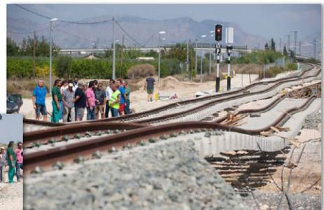
Detalle de los daños en la vía. Sentido del flujo de margen derecha a izquierda.
