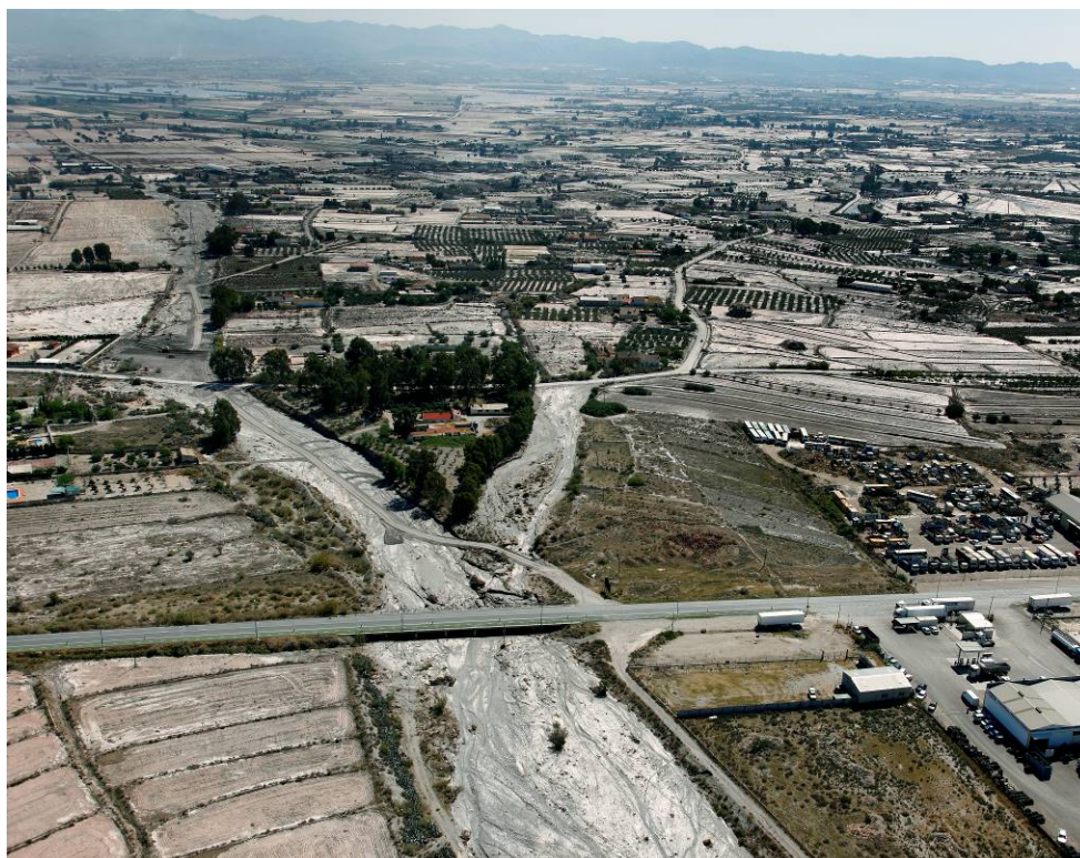
Avenida de San Wenceslao 2012. Llano de inundación al suroeste de Lorca en las pedanías de La Torrecilla y Campillo. En primer término se ve la rambla de La Torrecilla cruzando bajo la carretera N-340.
