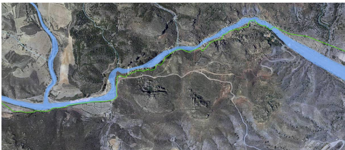
Vista general donde se ubicaría la presa. Se observan caminos sin asfaltar en la zona.
