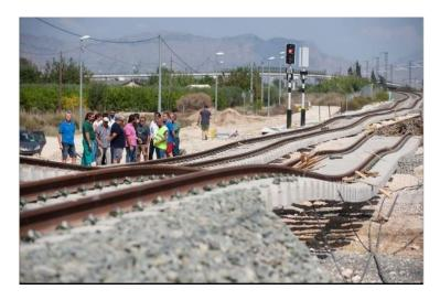
Figura 18. Plataforma del AVE tras el paso de la DANA, septiembre de 2019. Fuente: INECO-Adif.
