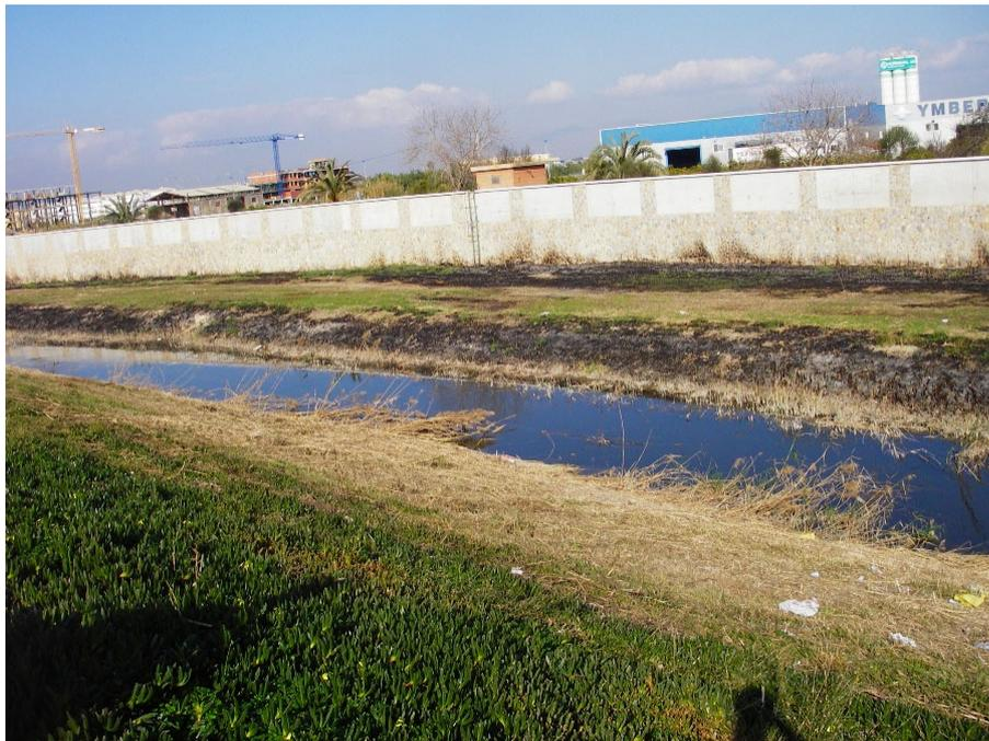
**Figura 7. Canalización trapezoidal realizada en tierra donde se intercalan tramos con obra de fábrica y mampostería. Río Segura en Rojales. Fuente: Comisaría de Aguas de la CHS.**
