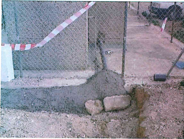
Recubrimiento de la tubería con hormigón en los distintos tramos.
