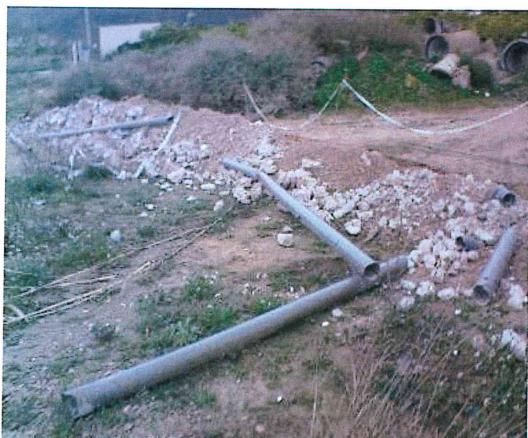
Excavación de la zanja y retirada del desagüe dañado.
