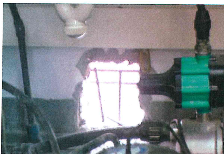
Pasamuros realizado en la caseta para la salida de la nueva tubería de desagüe al exterior.
