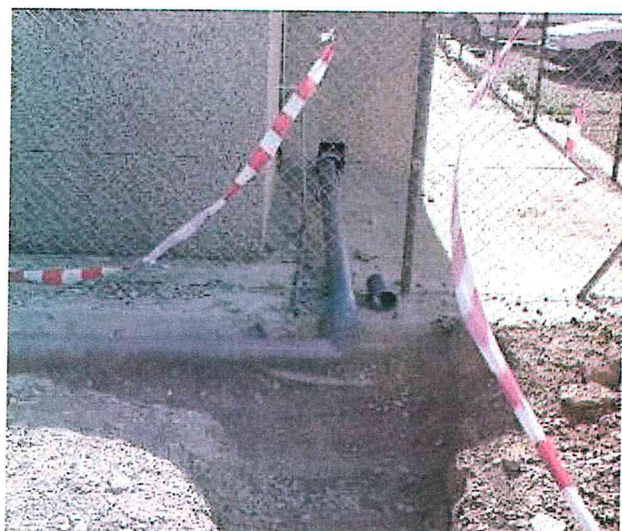
Nueva tubería de desagüe colocada
