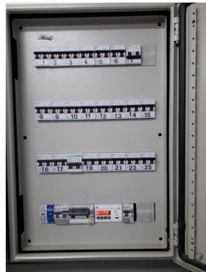
En la EAA de Contraparada (705-CO) se limpian filtros de la filtración. Se desatasca tubería de desagüe. Limpieza de sondas y analizadores. Se modifica cuadro eléctrico para añadir un diferencial rearmable que permita subir el diferencial de la estación en remoto.
