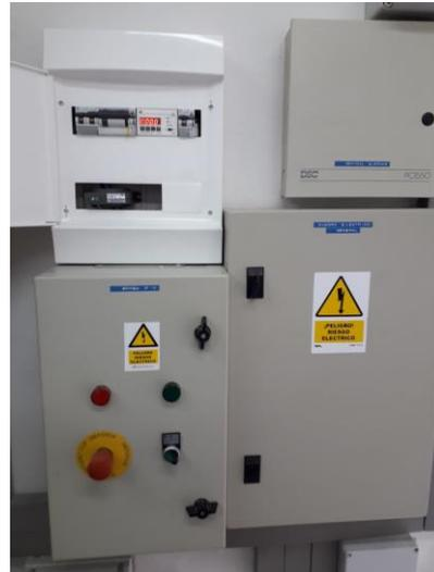
En la EAA de Ojós (702-OJ) se limpian filtros de la filtración. Se instala un rebosadero en el analizador de fosfatos por falta de caudal. Se sustituyen reactivos y fungibles en el analizador de amonio. Se detecta avería en el analizador de fosfatos. Limpieza de sondas y analizadores. Se modifica cuadro eléctrico para añadir un diferencial rearmable que permita subir el diferencial de la estación en remoto.
