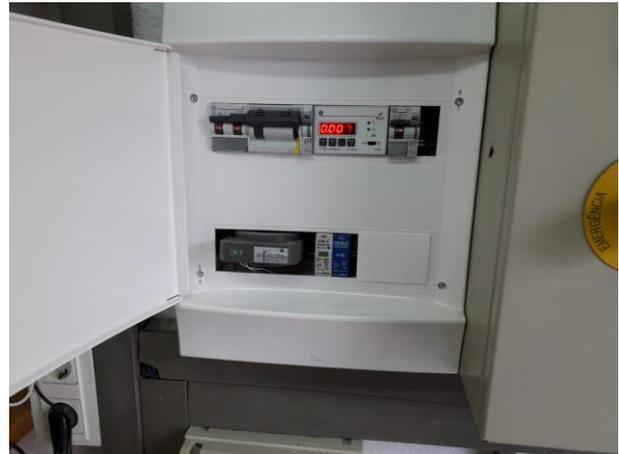
En la EAA de San Antón (708-SA) se sustituyen reactivos y se reparan averías en el analizador de amonio, se desatasca toma de agua de la filtración y se limpian filtros. Se localiza fallo que impide que se transmita señal de la sonda de concentración de oxígeno. Se detecta avería en la válvula de presión de la ultrafiltración. Limpieza de sondas y analizadores. Se modifica cuadro eléctrico para añadir un diferencial rearmable que permita subir el diferencial de la estación en remoto.
