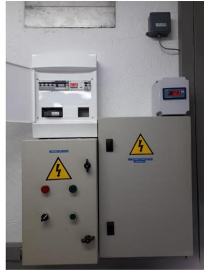
En la EAA de Archena (701-AR) se cambia el cable de la sonda de conductividad porque estaba averiado y calibración de dicha sonda. Se repara avería que afecta a la señal analógica del turbidímetro. Limpieza de sondas y analizadores. Se modifica cuadro eléctrico para añadir un diferencial rearmable que permita subir el diferencial de la estación en remoto.
