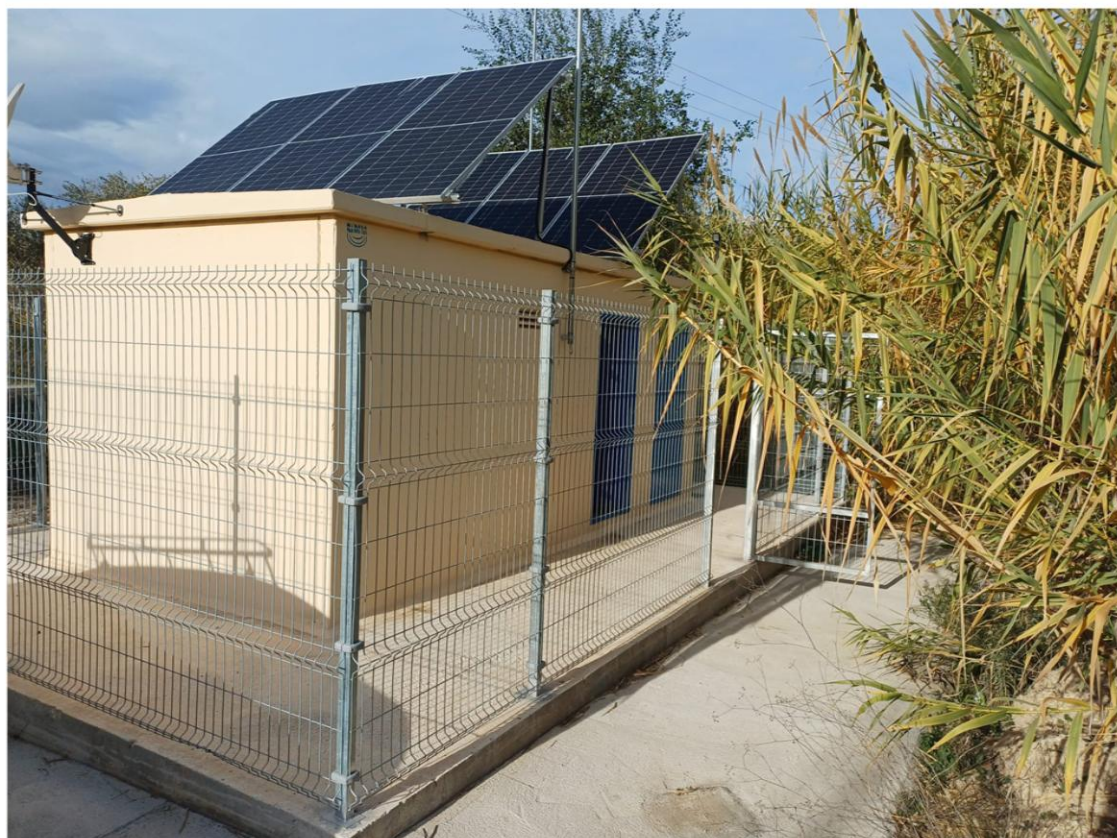
Foto 1. Exterior de la EAA de Molina de Segura.
